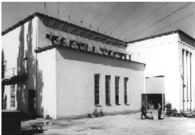
15-kV-Schaltheis des alten Umspannwerks Fallersleben, Hinterm Hagen / Erich-Netzband-Straße (1958)
