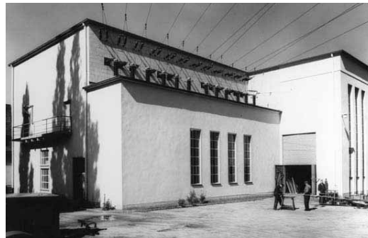
Links: Verladung von Holzmasten auf dem Lagergelände an der heutigen Herzogin-Clara-Straße in Fallersleben (1958), rechts: 15-kV-Schaltheim des alten Umspannwerks Fallersleben, Hinterm Hagen/Erich-Netzeband-Straße in Fallersleben (1958)
