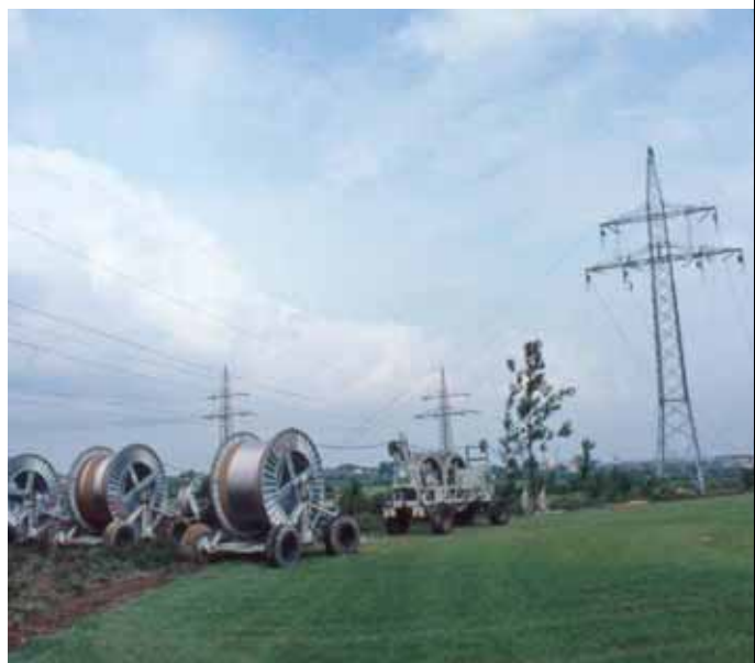
Seilzugarbeiten beim Neubau der 110-kV-Doppel-Freileitung Ahmstorf-Fallersleben (1985)
