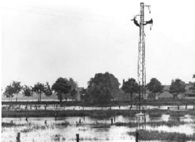
Freileitungsmontagen an einer 15-kV-Leitung bei Brome (1958)
