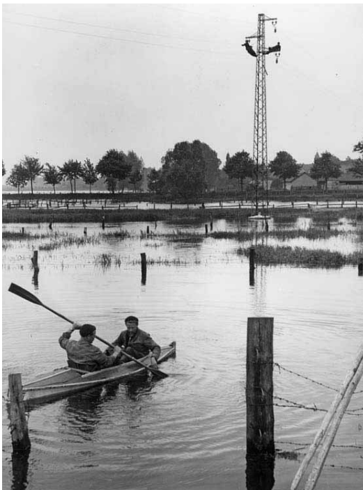
Freileitungsmontagen an einer 15-kV-Leitung in der überschwemmten Ohre-Niederung bei Brome (um 1958)
