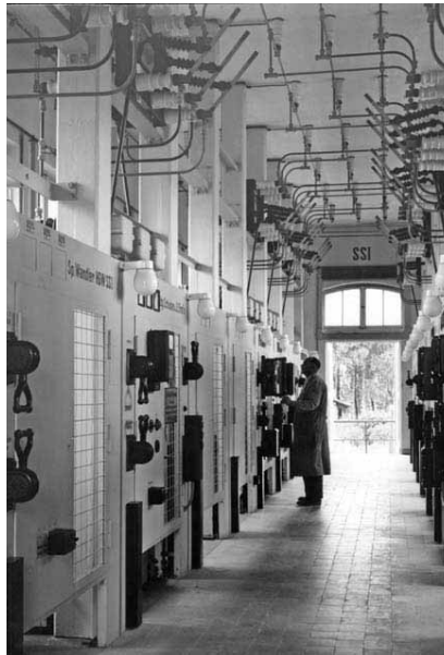
1958 noch Stand der Technik: 15-kV-Schaltanlage im Umspannwerk Schladen
