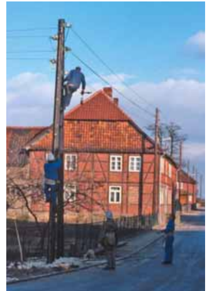
Montagearbeiten an einer Ortsnetzfreileitung in Almke im Frühjahr 1977
