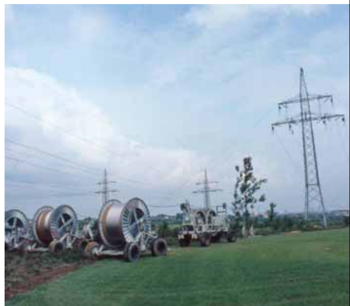
Seilzugarbeiten beim Neubau der 110-kV-Doppel-Freileitung Ahmstorf-Fallersleben (1985)
