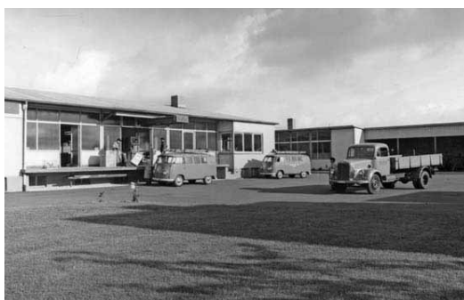
Betriebsstätte in der Herzogin-Clara-Straße in Fallerleben, 1958 und heute
